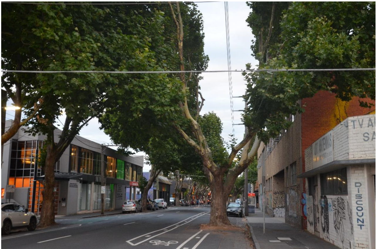
Photo 28 : Confrontation extrême entre arbres et infrastructure de réseaux (banlieue de Melbourne en Australie). Un alignement complet sur une rue a été « adapté » ou plutôt altéré et fragilisé par le passage d'un réseau aérien. Entre un alignement d'arbres ou l'implantation d'un réseau aérien : il faut choisir ! Crédit : Jérôme Champres
